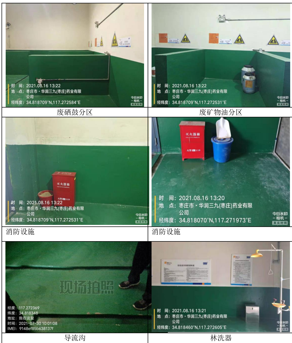
图 4.7-1 危废暂存间图
